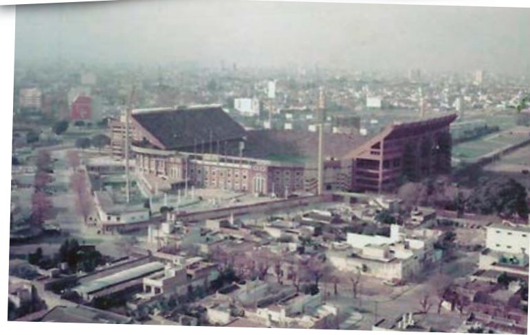
Estadio José Amalfitani antes de la construcción de la autopista
