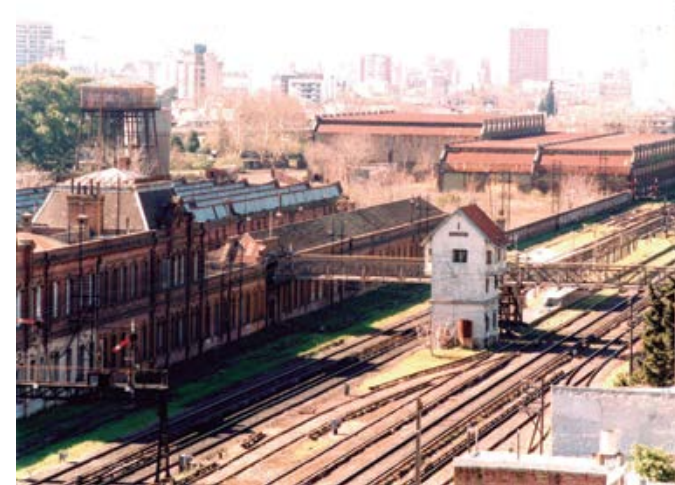
Vista del puente peatonal en Liniers Este
